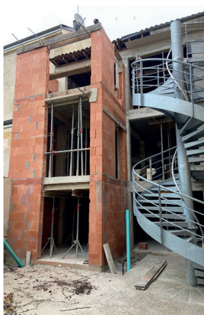
Cabinet médical, en travaux
