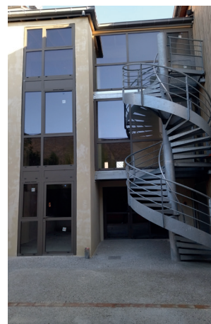
Cabinet médical, après travaux
